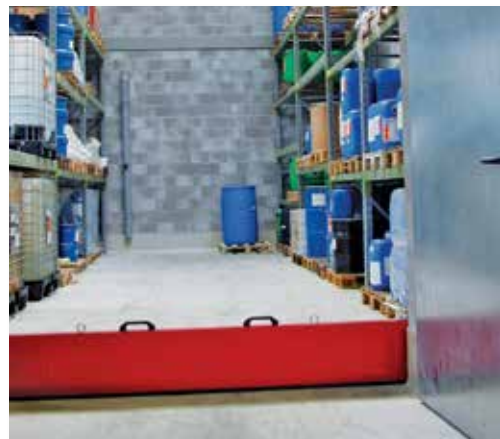
Leckage-/Löschwasserrückhalt (Bildquelle: Amt für Umwelt, Kt. TG)
